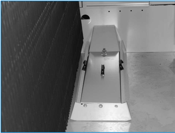
Kaltwasserbecken und Beckenlochblechsiebe
