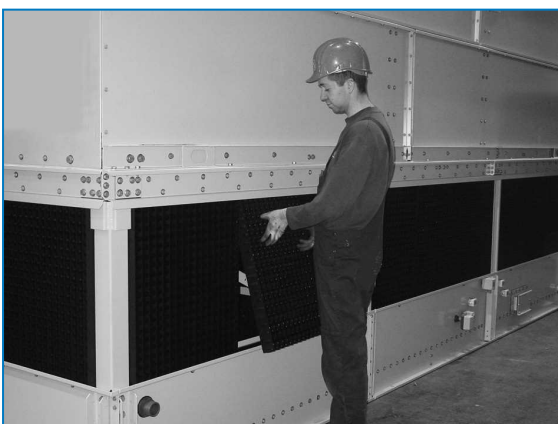
Kombinierte Lufteintrittsschutzelemente entfernen
