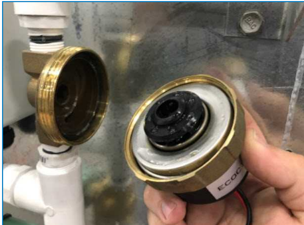
Pumpenkörper und Spiralgehäuse
