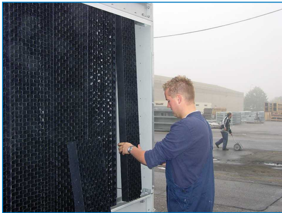
Kombinierte Lufteintrittsschutzelemente entfernen
