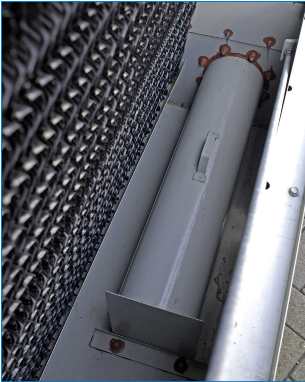
Kaltwasserbecken und Beckenlochblechsiebe
