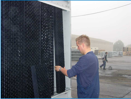
Kombinierte Lufteintrittsschutzelemente entfernen
