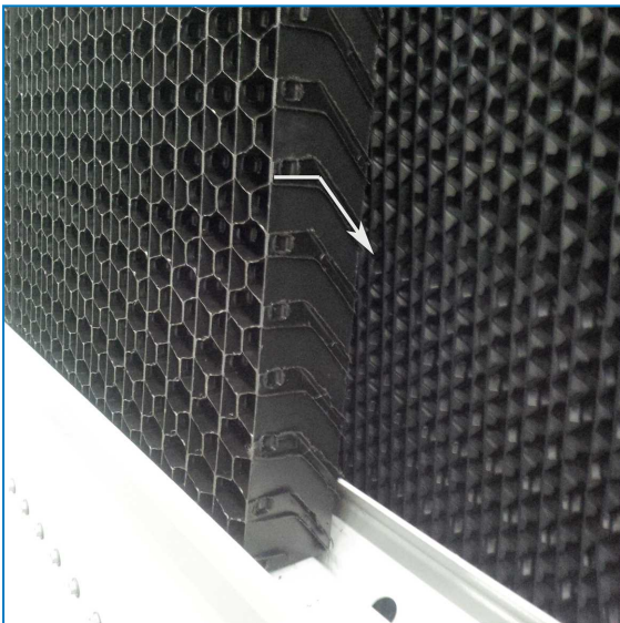
Ausrichtung des Lufteintrittsschutzelements
