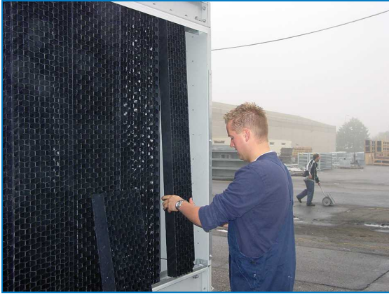
Kombinierte Lufteintrittsschutzelemente entfernen
