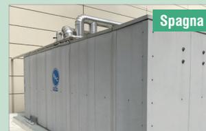
La tecnologia ad accumulo termico con ghiaccio è utilizzata per produrre e **accumulare raffreddamento quando i valori della richiesta di raffreddamento e/o di energia sono modesti**, per poi utilizzarlo per il condizionamento dell'aria o per scopi di processo quando detti valori sono elevati o in condizioni di emergenza.
