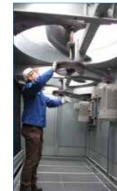
Sistema di trasmissione del ventilatore facilmente accessibile in piedi
