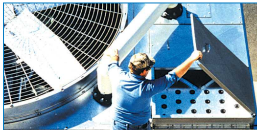
Vasca dell'acqua calda e coperchi bacino di distribuzione opzionali
