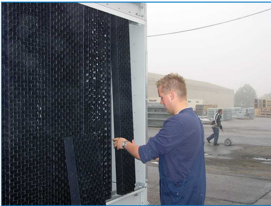
Rimuovere gli schermi d'ingresso combinati
