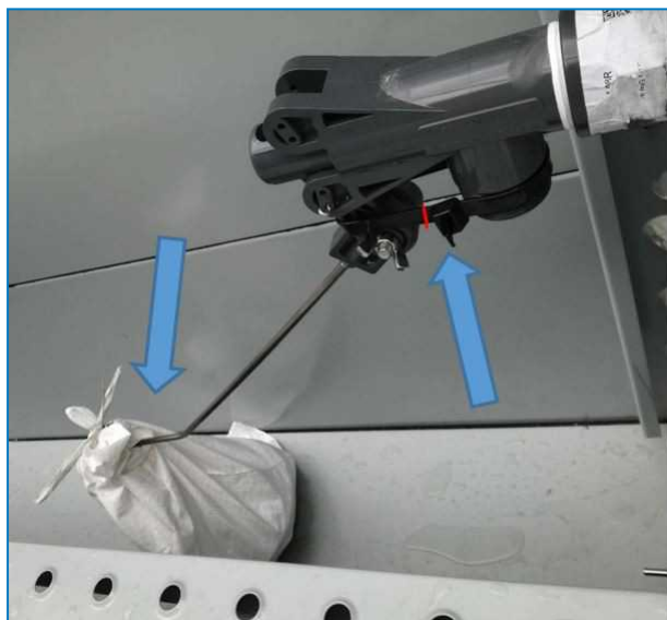
Fissaggio e avvolgimento della palla galleggiante
