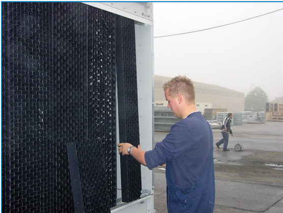
Rimuovere gli schermi d'ingresso combinati
