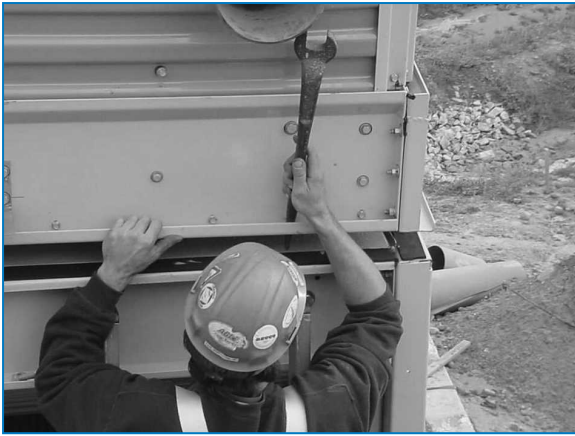
Alignement au coin avec la broche d'assemblage
