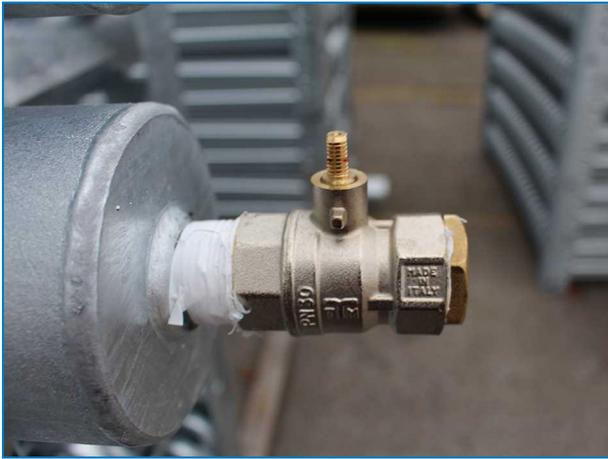
*Raccord de batterie supérieure avec soupape de décharge sur les condenseurs.*
