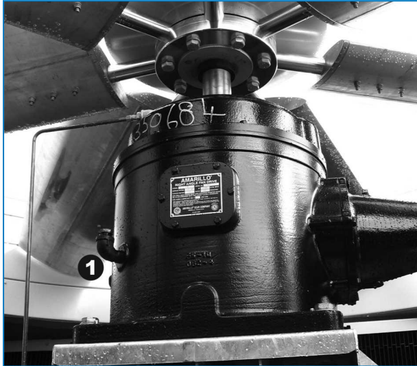
Transmisión por caja reductora con reducción simple
