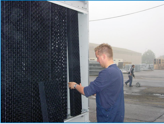
Retire los filtros de acción múltiple
