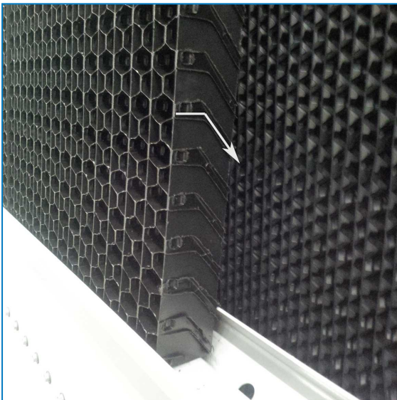
Orientation des déflecteurs d'entrée d'air à 3 fonctions
