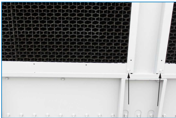
Démontage des sangles d'expédition
