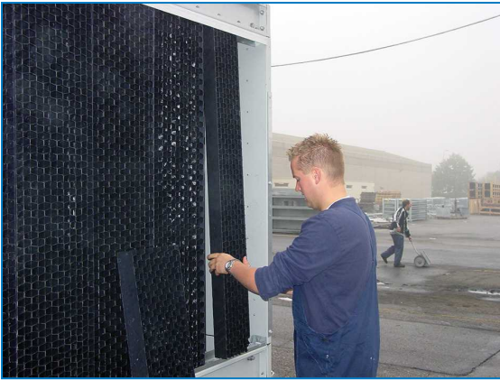
Démontage des déflecteurs d'entrée d'air
