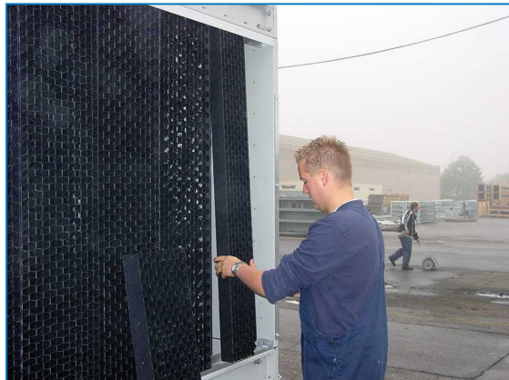
Démontage des déflecteurs d'entrée d'air
