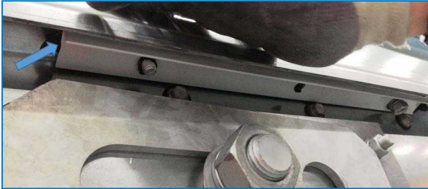
Perfil de sellado instalado
