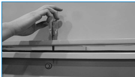
Utilizzo della spina di assemblaggio per allineare i fori di fissaggio
