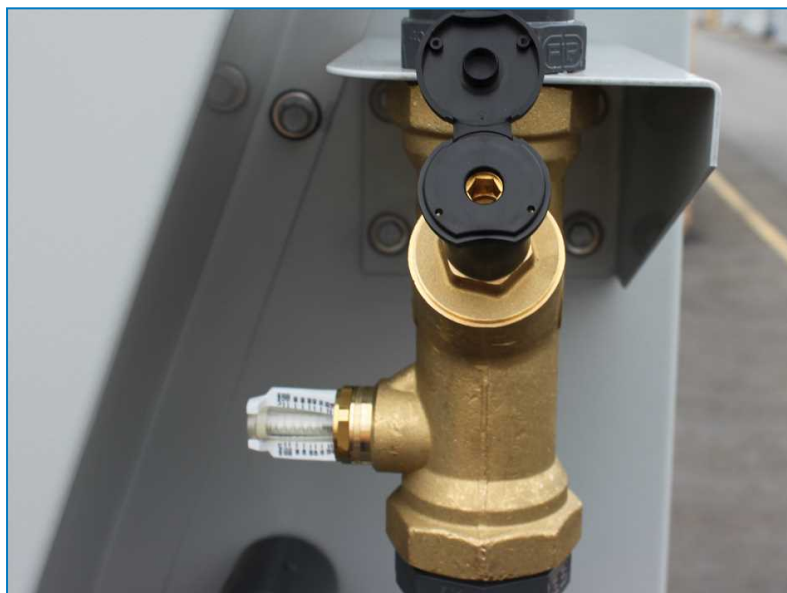
Винт регулировки расхода воды
