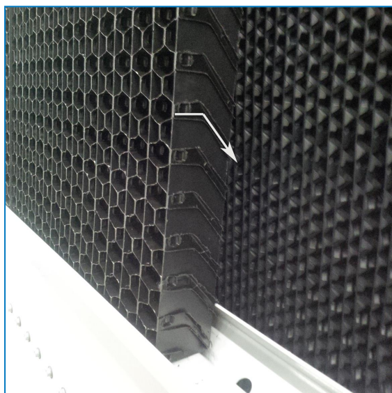
Ориентация комбинированных экранов на входе
