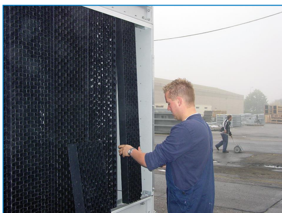
Снятие комбинированных щитов на входе
