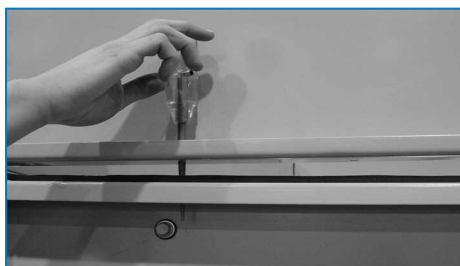
Использование штифта для выравнивания резьбовых отверстий
