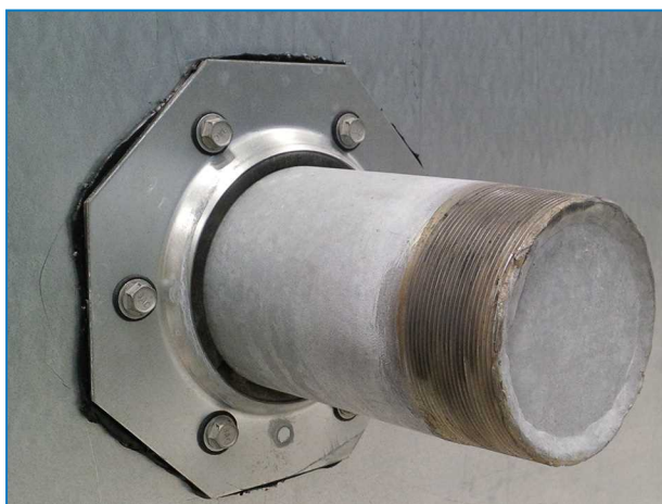
Соединение низкого перекрытого теплообменника (в градирнях закрытого типа с соединениями до ND100).
