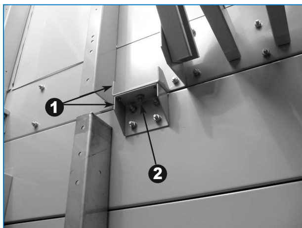
Секция вентиляционной камеры, смонтированная на нижней секции
