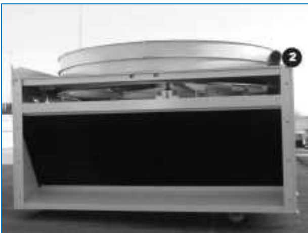
Подсоединение трубопровода насоса на секции вентиляционной камеры, вид снаружи
