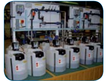
Instalación de BCP
