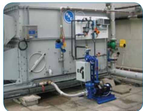
Instalación del sistema de filtrado
