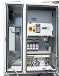
**Jetzt sind Steuerungen für adiabatische Geräte mit VFD-Antrieben für die Umrüstung** älterer, punkt geregelter Geräte mit zusätzlichen Funktionen und Vorteilen verfügbar: weniger Geräusche, weniger Wasser- und Energieverbrauch.
