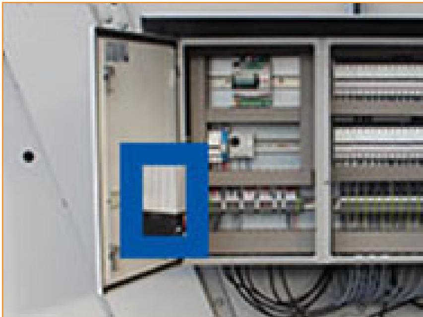
Die Standard-Elektrokonsole ist für die Installation bei Umgebungstemperaturen bis  $-10\text{ °C}$  ausgestattet. Für Klimazonen, in denen die Umgebungstemperatur noch niedriger sein kann, kann eine elektrische Heizung Schäden an den inneren Komponenten in der Elektrokonsole für Umgebungstemperatur bis  $-40\text{ °C}$  verhindern.
