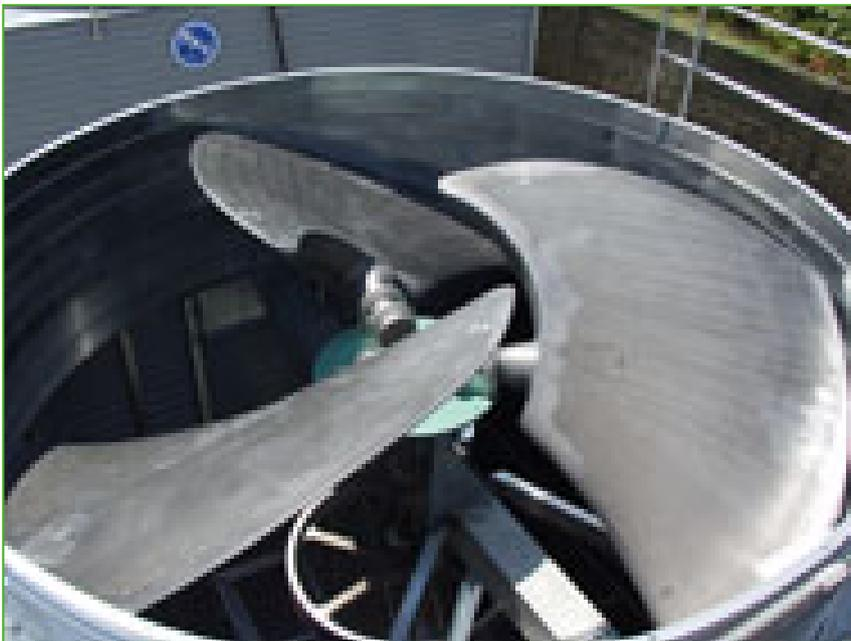
**Leise und wirtschaftliche Axiallüfter** bedeuten, dass FXVT-Kühltürme nur wenig Lärm machen. Um die Geräuschentwicklung noch weiter zu verringern, sollten Sie sich für **flüsterleise Lüfter** als Alternative entscheiden, die mit Aluminium-Scharnierlüfterblatt-Design und einzigartigen Endkappen für optimale Geräuschreduzierung sorgen.
