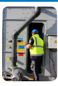
Porte d'accès le côté opposée*
