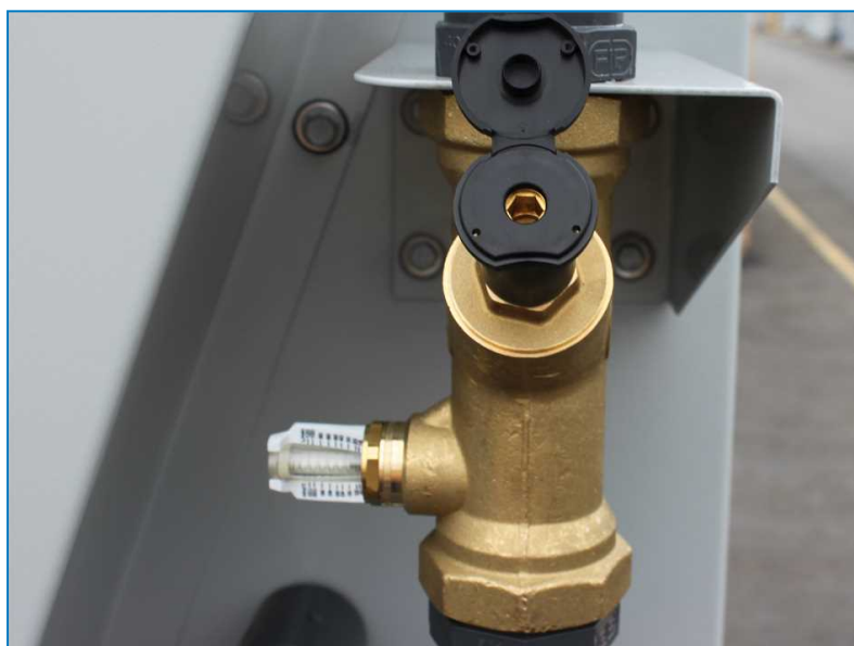
Śruba do regulacji przepływu wody
