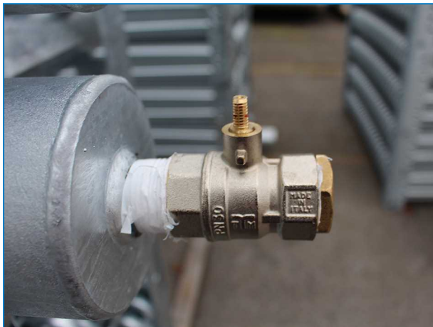
Oberer Rohrbündelanschluss mit Überdruckventil auf Verdunstungsverflüssigern.
